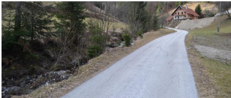
Cesta posega v varovalni pas potoka, ki je definiran kot odmik osno 5m v vsako stran od sredine struge
